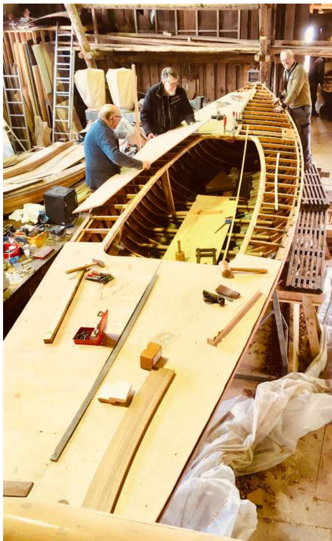
4/4 2019: Pålægning af nye plywoodplader i dækket.
