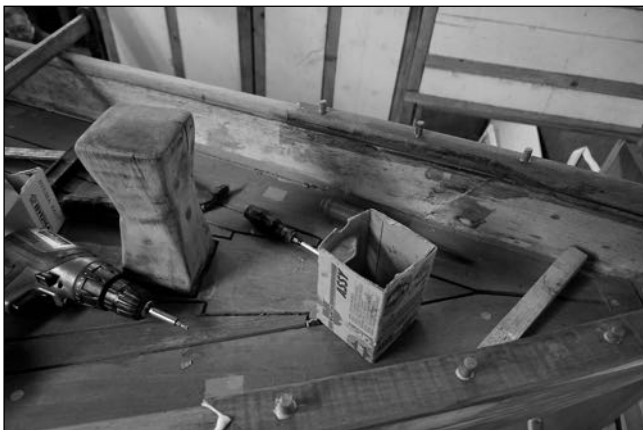
Fordækket under renovering.
