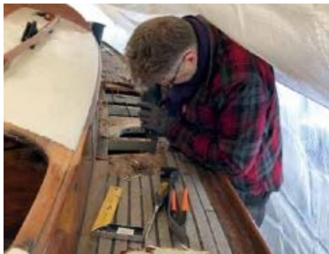
Finecutteren er uundværlig til bådreparationer
