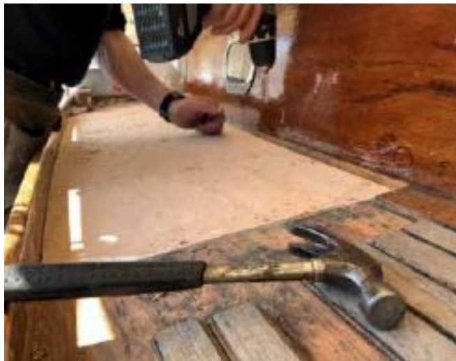
Der luses ud i det gamle underdæk
