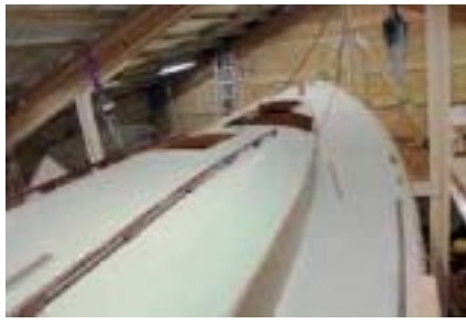
Det gamle lærredsdæk er forlængst erstattet af et glasfiberdæk
