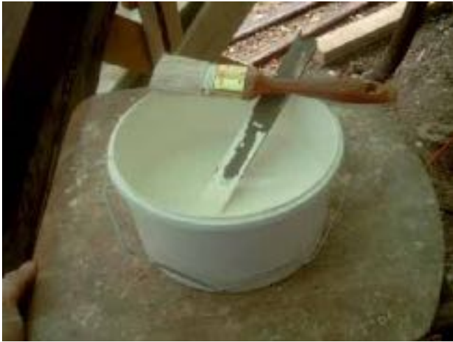
Bøtten med hvid linoliemaling og den gode anstryger. Første strygning er i gang.
