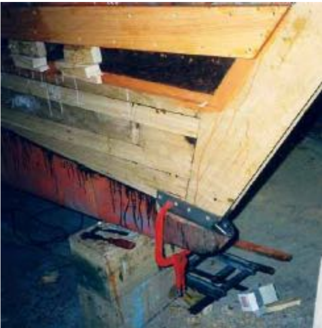
Ny agterstævn ved reparationen i 1999
