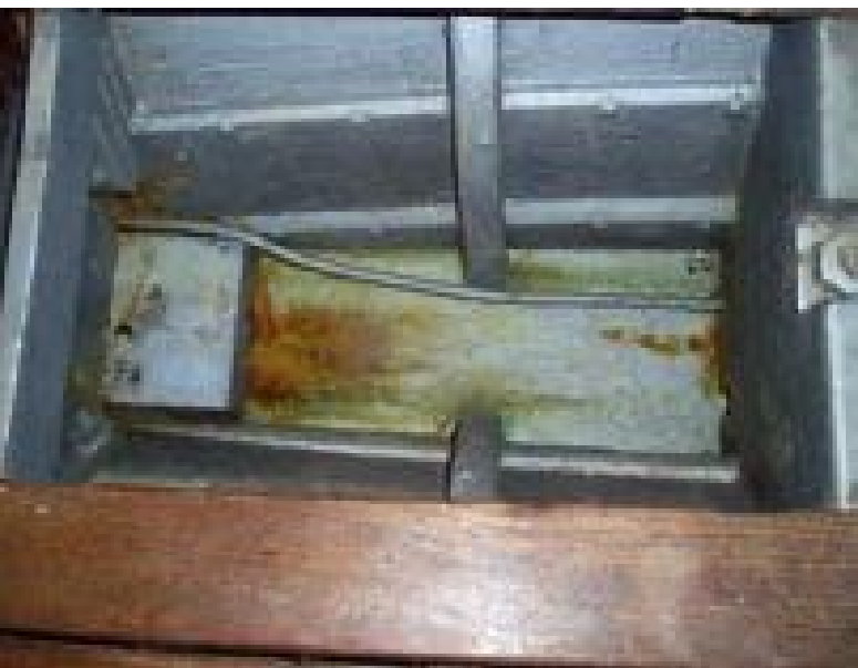
Ruststriberne ved kølsvinet er tegn på, at jern- eller stålmateriale er omdannet til rust uden styrke
