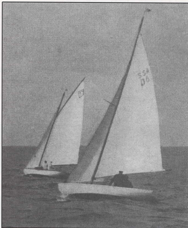
Her dyster SSA D6, Skjoldungen, med Maagen "Jenten". Som man tydeligt ser, kan SSA-båden holde bedre højde end den gaffelriggede Maage.
