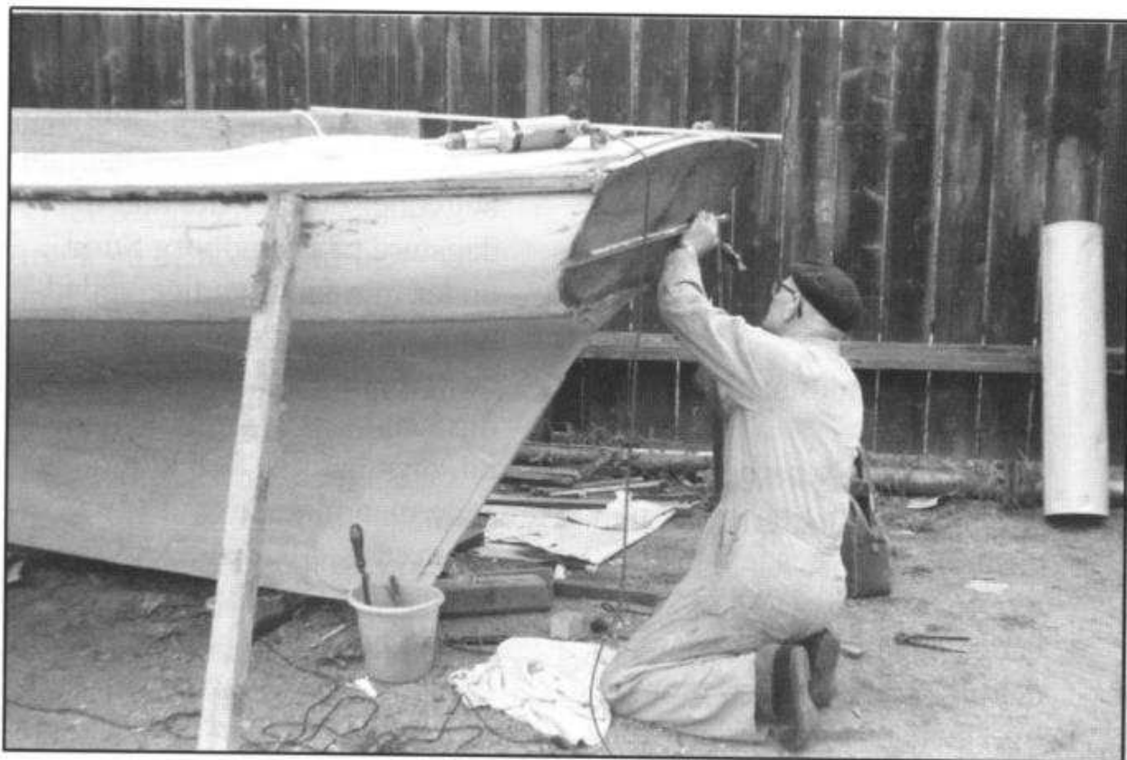
Min far er her ved at reparere agterspejlet. Båden ses forsynet med en forstærkning af galvaniseret jernplade p.g.a. råd agterst i kølen. Pladerne er nu af messing.
