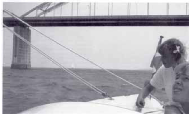
Under storstrømsbroen – på sommertogtet med "Vuska" i 1963
