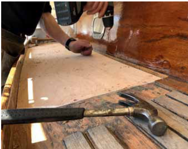
Der luses ud i det gamle underdæk
