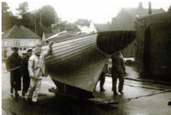
Billedet af transporten er taget på Lerchesvej, med Ørkildsgade i baggrunden. Det var en gammel Scania lastbil, der trak. Der blev ikke brugt ruller, men en tretommer bøgeplanke, der blev fornyet, når den blev for tynd, og der var ingen smørelse.
