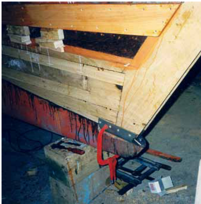
Ny agterstævn ved reparationen i 1999
