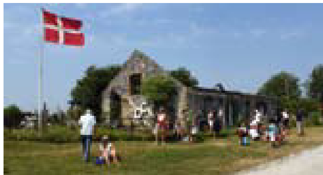
Nogle af bygningerne på Saltholm bærer præg af, at de har været ubeboede i snart 100 år
