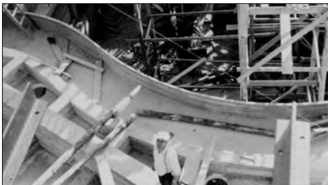
Fredericia Teater under genopbygning 1953-56.
